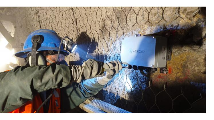
Una importante empresa minera en Perú quería medir los desplazamientos en el túnel donde se encuentra su cinta transportadora de minerales. Requerían lecturas confiables del movimiento de las rocas cada seis horas y a lo largo del túnel de dos kilómetros. El monitoreo se dificultaba por interferencias de señal causadas por ruido de radio, campos magnéticos, metales, tuberías y otras obstrucciones de la mina.
