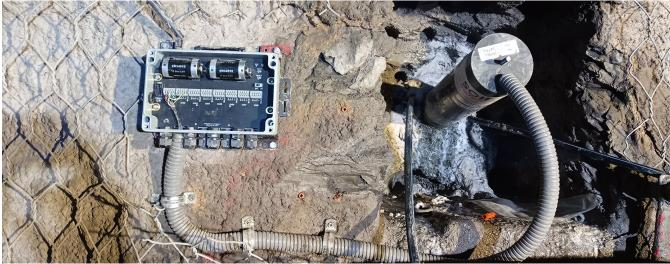
Geoteknik conectó los nodos Ackcio VW (BEAM-VW-S8) a siete extensómetros de varilla multipunto instalados en los ejes derecho e izquierdo del túnel a lo largo de la cinta transportadora de la mina. También instalaron tres nodos repetidores Ackcio (BEAM-RN) para garantizar una cobertura total de datos. La puerta de enlace Ackcio (BEAM-GW) en la superficie se conectó a la red Ethernet de la mina, que comparte los datos con el software Snape de Ackcio.
