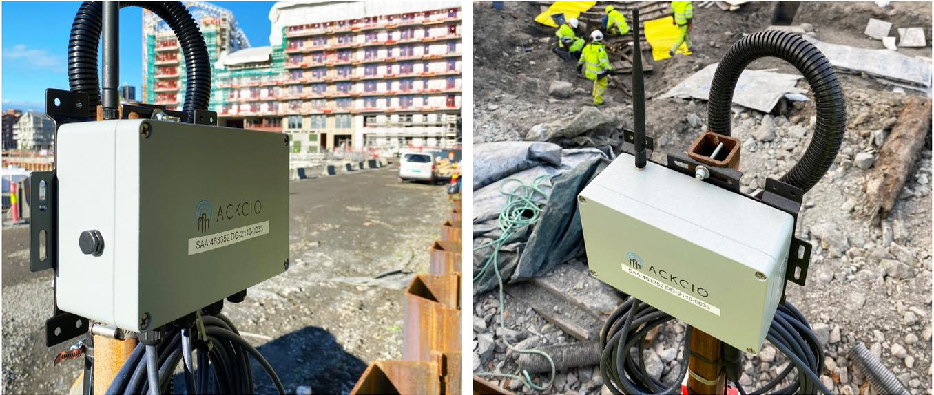
**El cliente de Cautus Geo quería un sistema de monitoreo remoto que fuera confiable y eficiente. Eligieron la solución inalámbrica de Ackcio para evitar el uso de cables en la transmisión de datos a lo largo de las tablestacas.**
